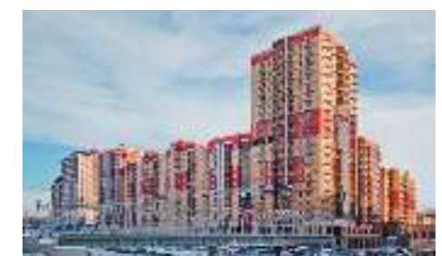
ЖК «Солнечный город», Казань «АК БАРС Строй»
